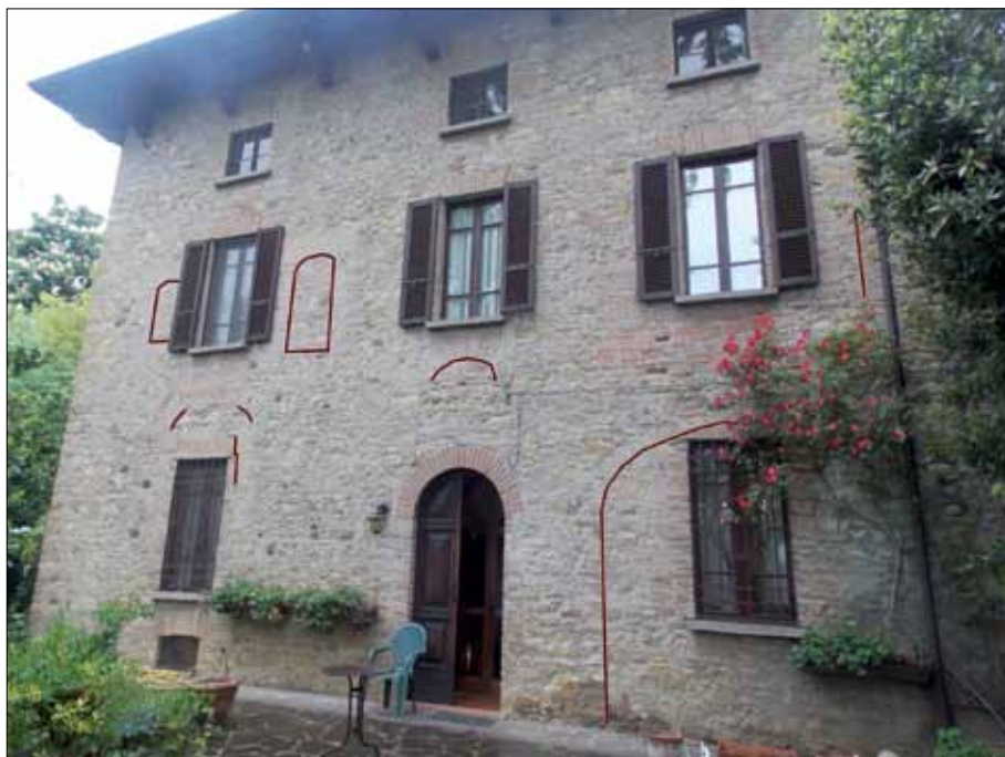
Fig. 14: L'edificio visto da sud.
