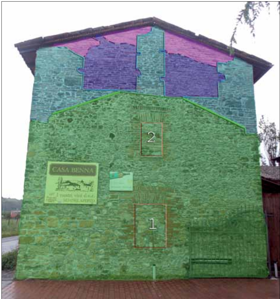
Fig.6: La parte colorata in verde indica la prima fase costruttiva; la linea verde netta invece indica la traccia visibile del colmo di tetto di questa prima fase. Una prima sopraelevazione ha creato un fienile (fase azzurra ) poi successivamente tamponato (fase blu ; si notino i mattoni di “immorsatura” nei pilastri). La fase viola indica alcuni rifacimenti localizzati in prossimità del tetto. Si nota infatti una netta differenza tra i mattoni della fase Blu con quelli della viola. Le finestre tamponate 1 e 2 paiono essere coeve alla fase verde.
