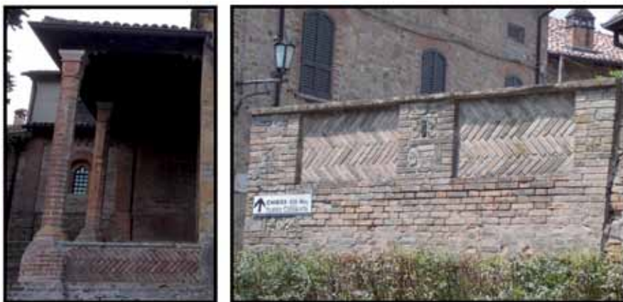
Fig. 16: Esempi di mattoni a "spina di pesce" in alcune ristrutturazioni neomedievali a Castell'Arquato. A sx a lato della collegiata mentre a dx nella piazzetta a fianco la Rocca.
