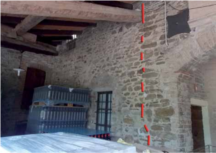
Fig.12: La linea rossa tratteggiata indica il confine tra due fasi costruttive differenti; in base all'osservazione del tessuto murario la parete di sinistra è verosimilmente successiva rispetto a la parete di destra. In base alle misure della mappa del '700 a questo limite corrisponderebbe il confine tra le particelle 231/239 con la particella 229. Questo confine sembra rimasto lo stesso nel catasto dell'800 tra le particelle 287/288 con la 285.
