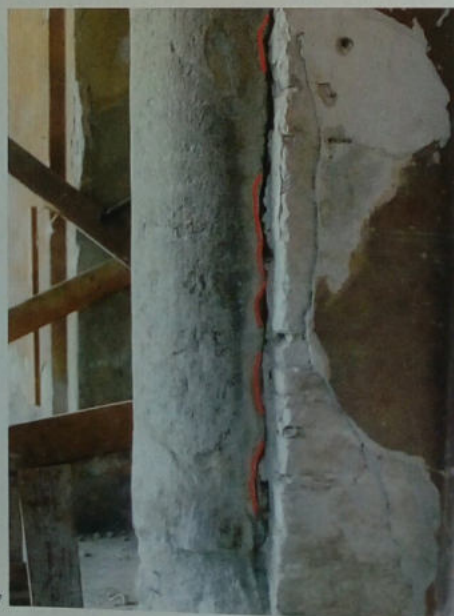
Fig. 11 - Pilastro sinistro incorniciante il grande accesso visto dal cortile del chiostro. Il pilastro 1 è in appoggio (freccie nere) rispetto alla parete 2 ma anche alla fase A indicata col giallo ed alle fasi A1 e A2. Con la fase A si indica la ghiera laterizia originaria ed in parte murata, mentre con A1 un giro di mattoni inseriti "di piatto" che ricorre intorno la ghiera. Con A2 si indica invece un frammento di arenaria recante tracce di modanatura: su di esso poggia l'arco A. La fase viola B è invece la nuova spalla connessa al pilastro 1 (graffa per indicare che i due elementi "legano") che invece è in appoggio all'antica soglia della parete di fondo 2
