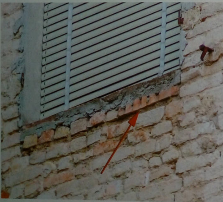
Fig. 26 - la freccia indica il laterizio di reimpiego
