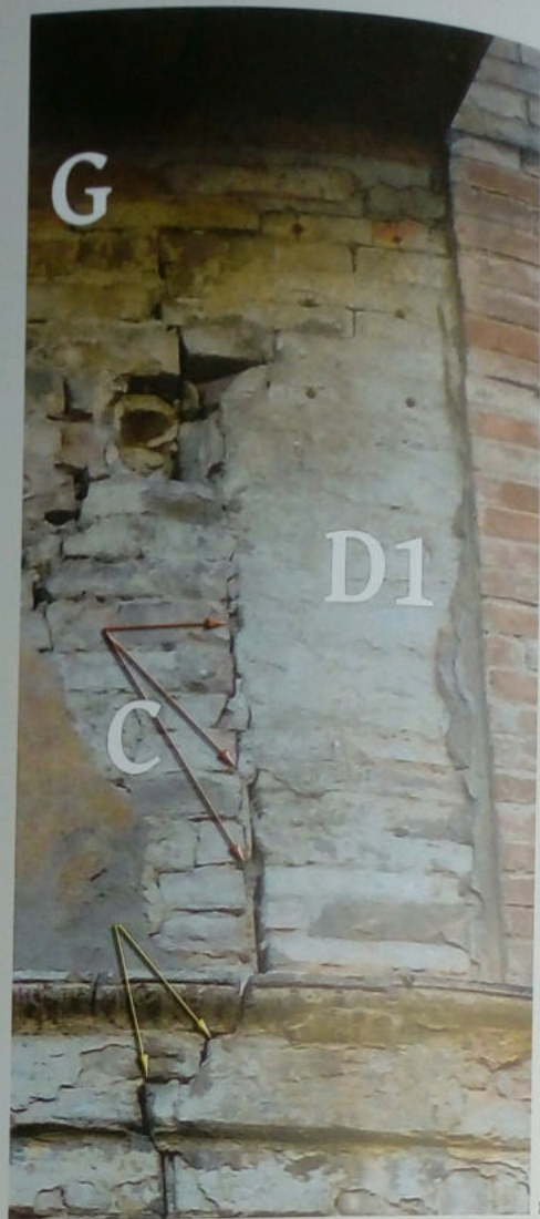
Fig. 8 - Con le lettere si indicano le corrispettive fasi murarie indicate in tavola dedicata. le frecce rosse indicano l'ex stipite di finestra, mentre le gialle la lesione.
