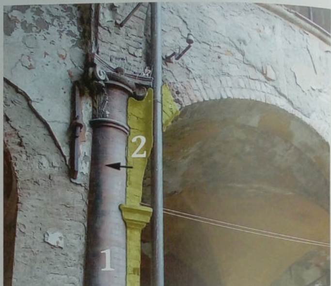
Fig. 24 - la fase gialla 2 è in "appoggio" (freccia nera), e quindi successiva, alla colonna in cotto numero 1. Con la realizzazione della fase gialla è stato rifatta anche una piccola porzione di arcata del contiguo loggiato est del chiostro. Nella fase gialla si utilizzano mattoni di esiguo spessore (tra i 4 e i 5 cm)
