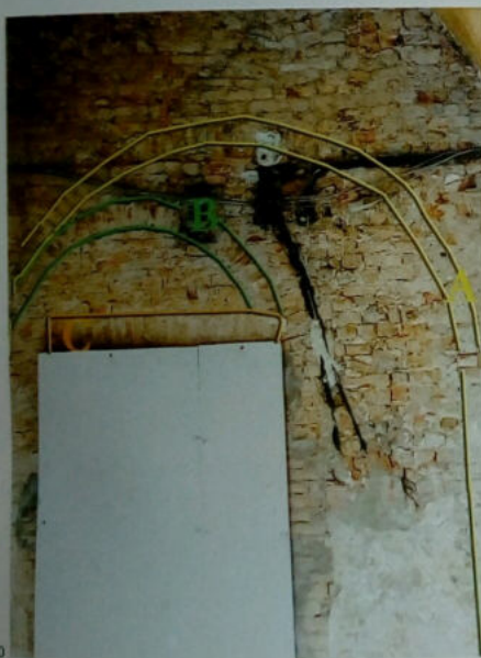
Fig. 19 - con la linea rossa si delinea l'apertura tamponata più antica, mentre con il giallo l'arco successivo. la spalla di questi si appoggia ad un precedente stipite risagomato e segnato con il verde. Con la superficie colorata di rosso si evidenzia la più antica e regolare porzione muraria con giunti caratterizzati da stilature in malta Fig. 20 - In giallo e con A si evidenzia arco più antico, simile a quello della fig. 19. Ad esso si appoggia l'arco segnato in verde e con la lettera B. Quest'ultimo è stato poi sostituito dall'attuale piattabanda C. L'arco B e la piattabanda C con le rispettive murature adiacenti sono caratterizzati da laterizi aventi spessori attorno i 5 cm Fig. 21 - presunto stipite tondeggiate di portale. Sulla sinistra della foto si nota la spalla dell'arco poggiante su di esso Fig. 22 - Si nota a sinistra la foto della Tria, mentre sotto il suo rilievo.
