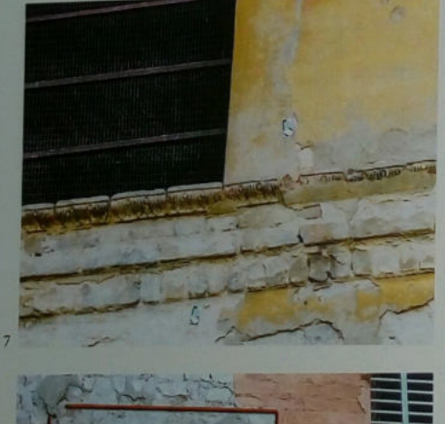
Fig. 10 - Dettaglio di finestra del prospetto meridionale. Con la linea rossa è segnato il profilo della finestrella rinascimentale rettangolare. Confrontandola con le tracce meglio conservate nel disimpegno precedentemente descritto, possiamo indicare con la freccia gialla la prima parte dello stipite originario, costituito da mattoni levigati ed inseriti tutti "di testa" nel muro. Con la freccia arancione si indica la modanatura sporgente distrutta e con la freccia verde un riempimento laterizio tra la finestra e la soglia del muro, evidentemente dovuto ad aggiustamenti in fase di lavoro per la non completa aderenza tra gli elementi collocati dello stipite e la parete. Con il colore rosso si segna invece il tamponamento della finestra più antica e la conseguente realizzazione della nuova con i relativi elementi costitutivi.
